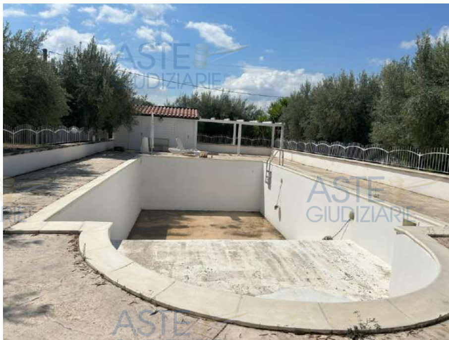
PISCINA CON CORPO SPOGLIATOIO
