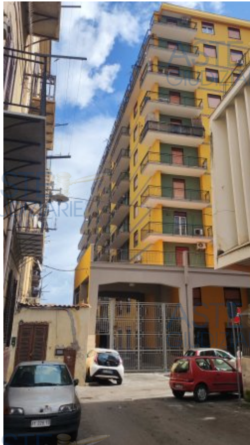
Foto n. 1 – Prospetto principale del corpo di fabbrica
