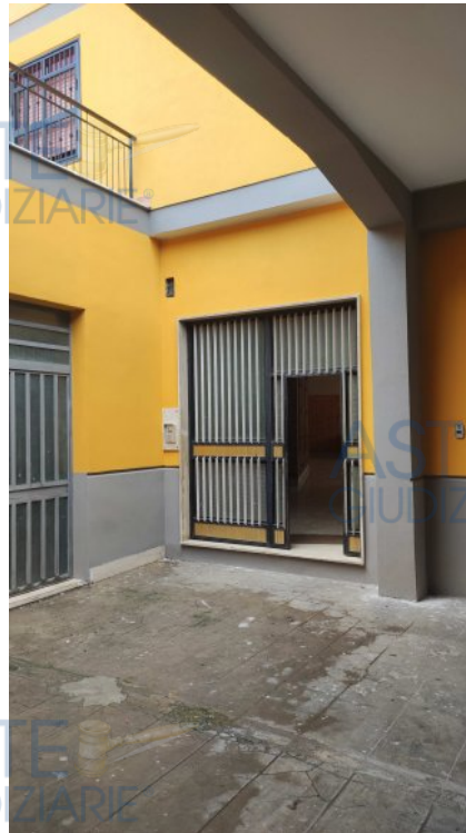
Foto n. 2 – Portone di accesso civ.31 via Stanislao Cannizzaro
