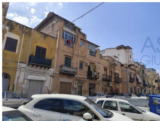
Vista del fabbricato sulla via Brancaccio (F.2)
