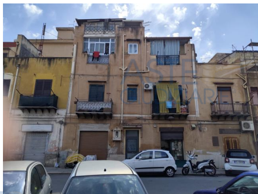
Vista del fabbricato sulla via Brancaccio (F.1)
