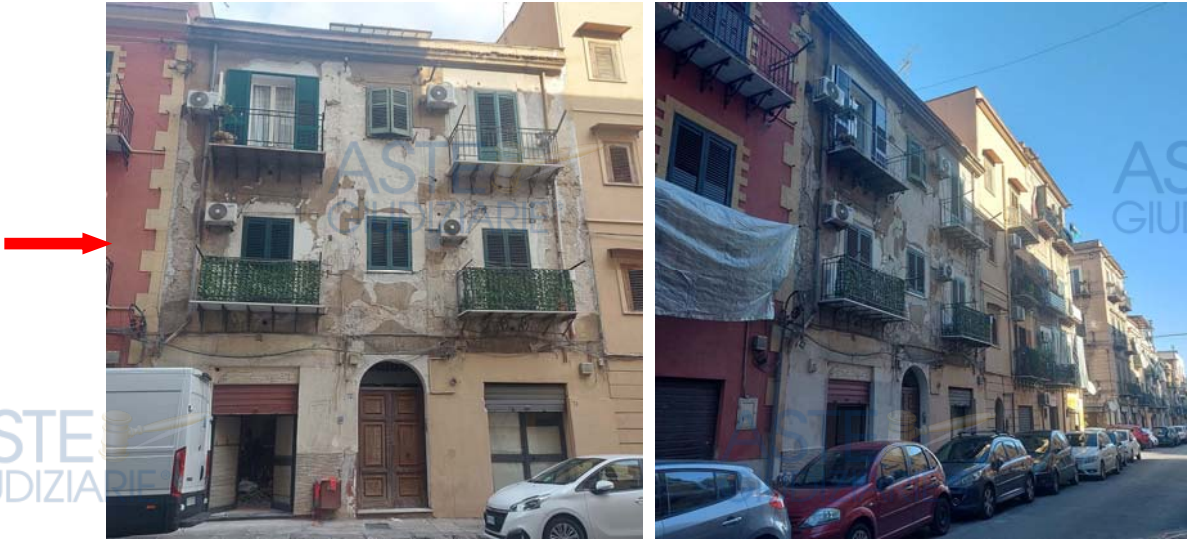
FOTO 1 – 2 Prospetto via Archimede n. 77 - Palermo
