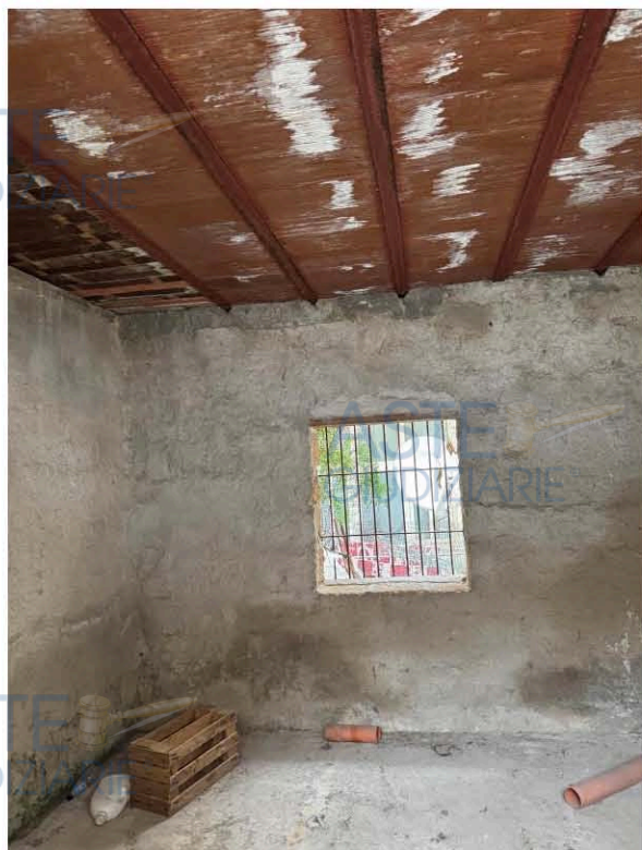
Foto n. 4 - Interno della camera coperta da solaio
