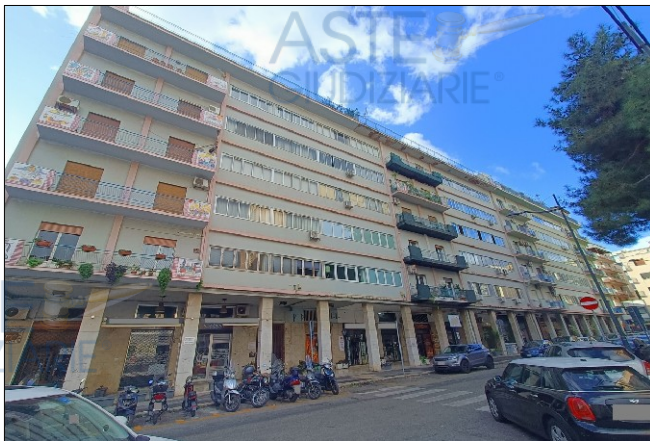
Foto 1 - Vista del prospetto su via E. Onufrio
