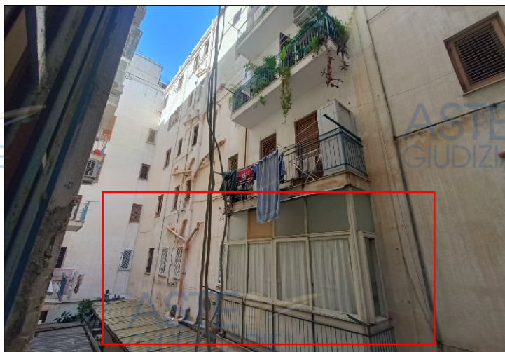
Foto 25 – Veduta del retroprospetto su cortile interno
