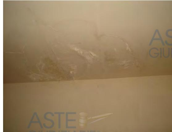
Foto n. 17 - Soffitto camera con umidità (piano 2°)
