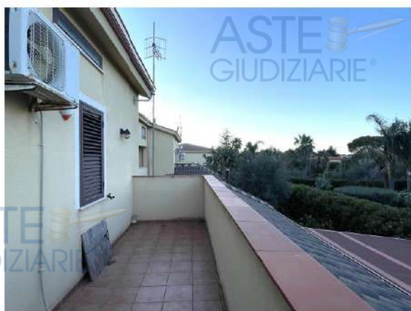
Piano primo – Terrazzo fronte nord
