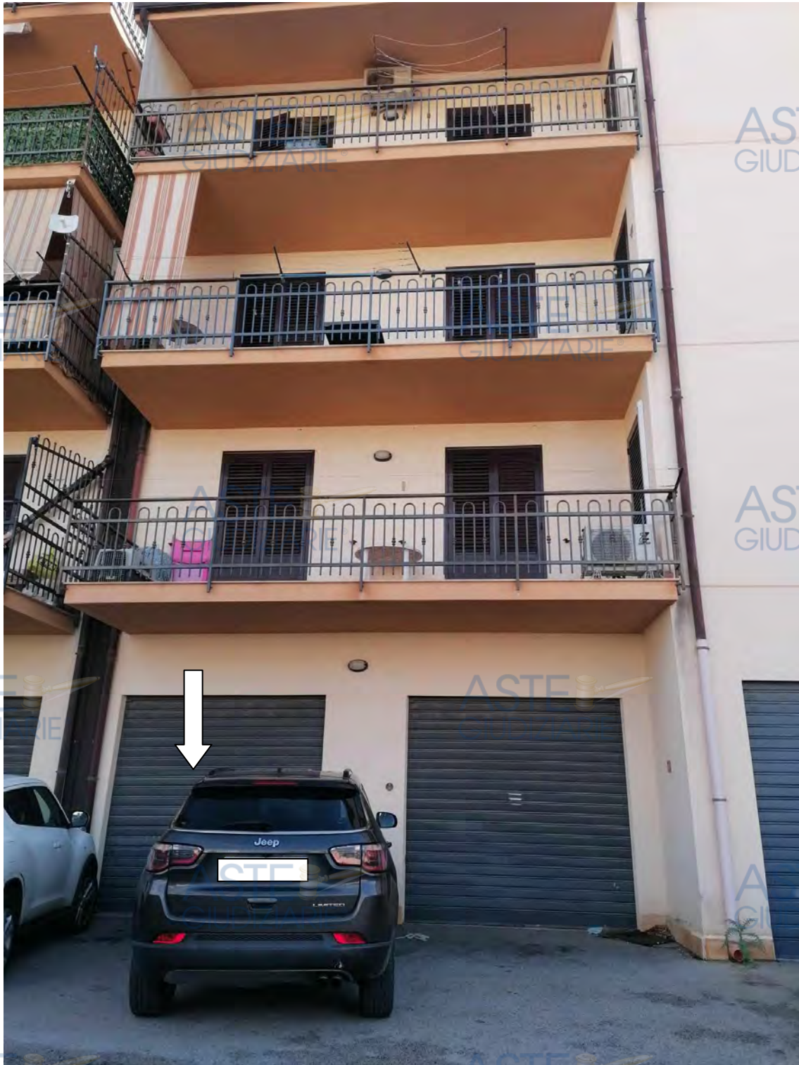
Foto n. 4 – porta di ingresso all'locale garage dalla strada di lottizzazione
