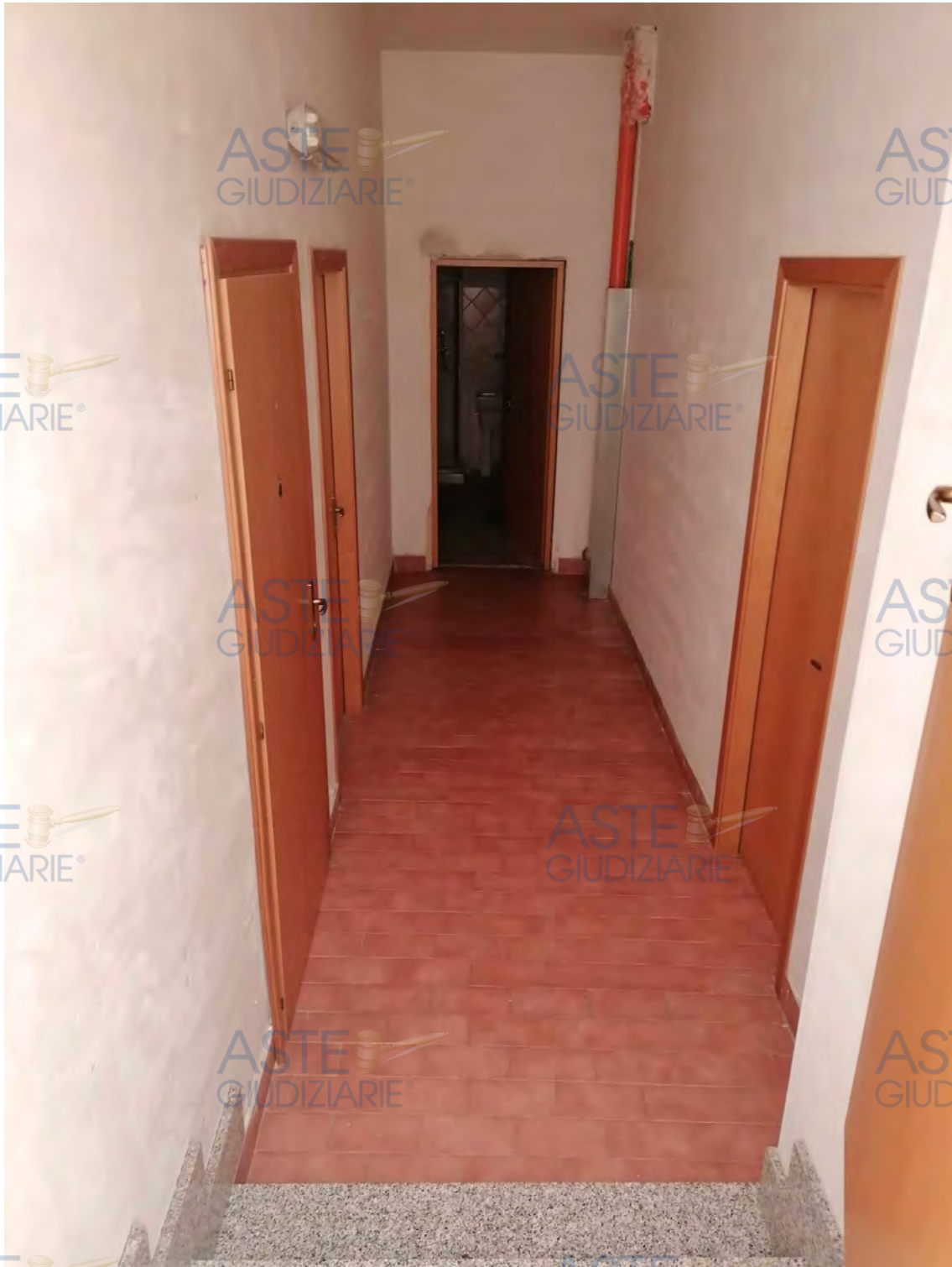
Foto n. 3 – corridoio condominiale e ingresso locale garage
