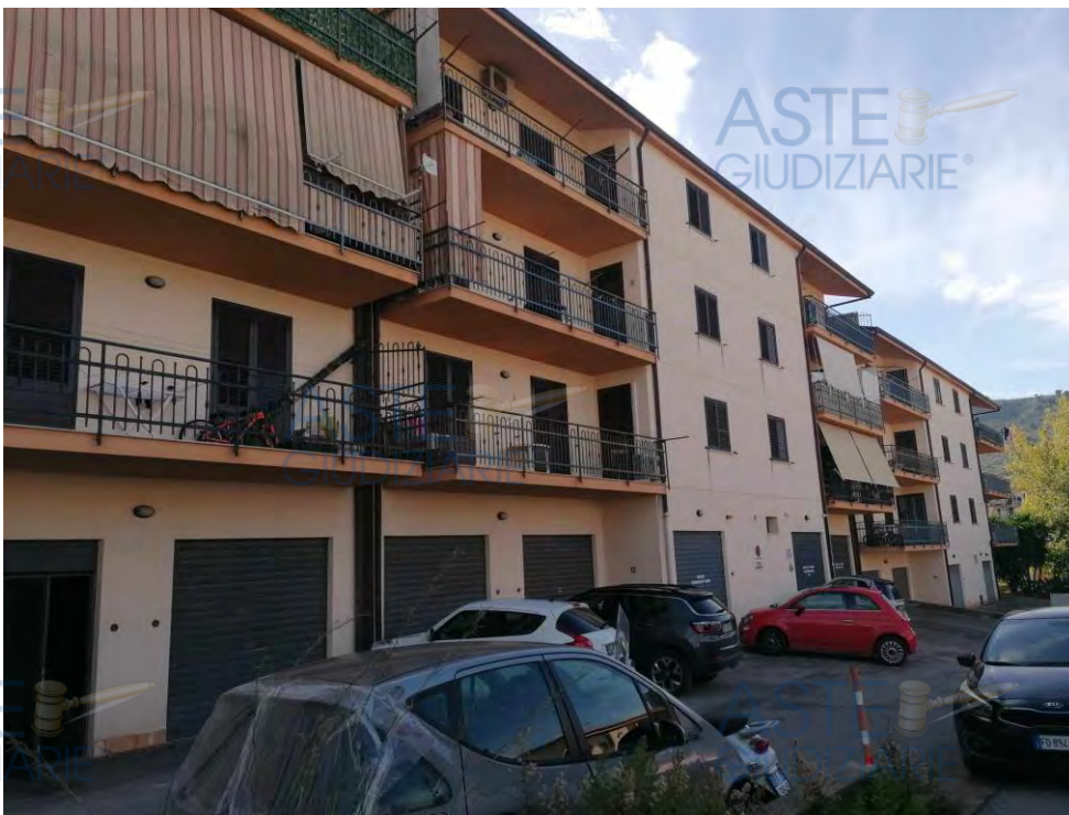
Foto n. 1b– prospetto secondario e strada di accesso ai locali garage
