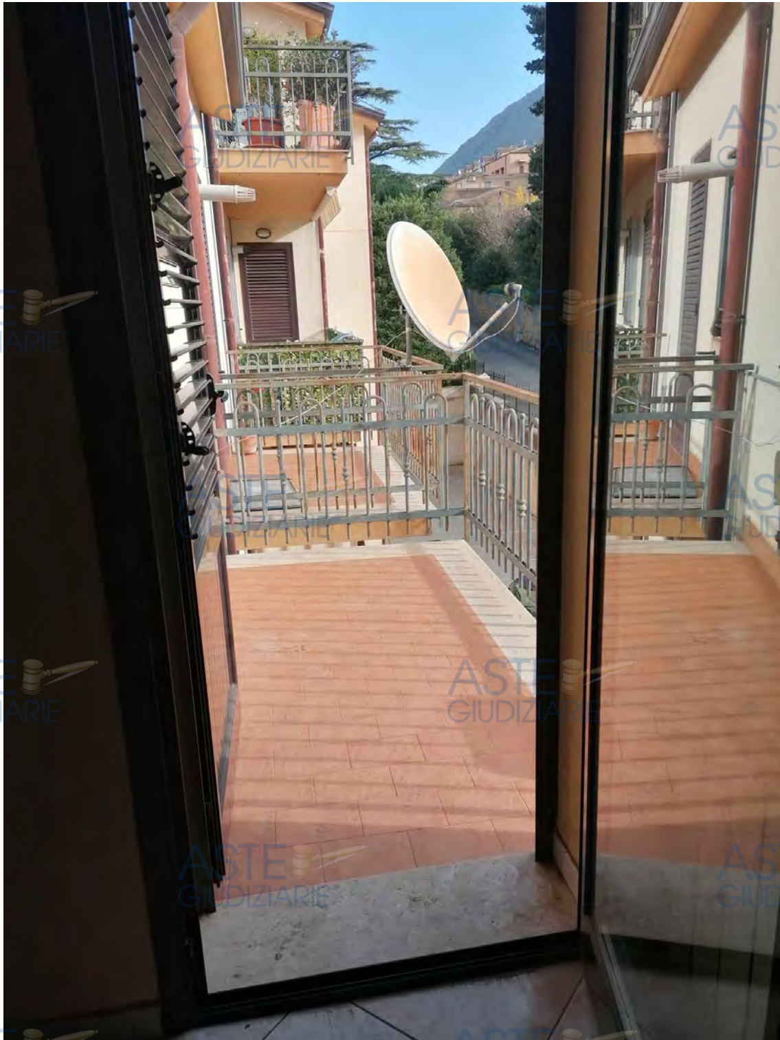
Foto n. 14 – balconi prospetto principale
