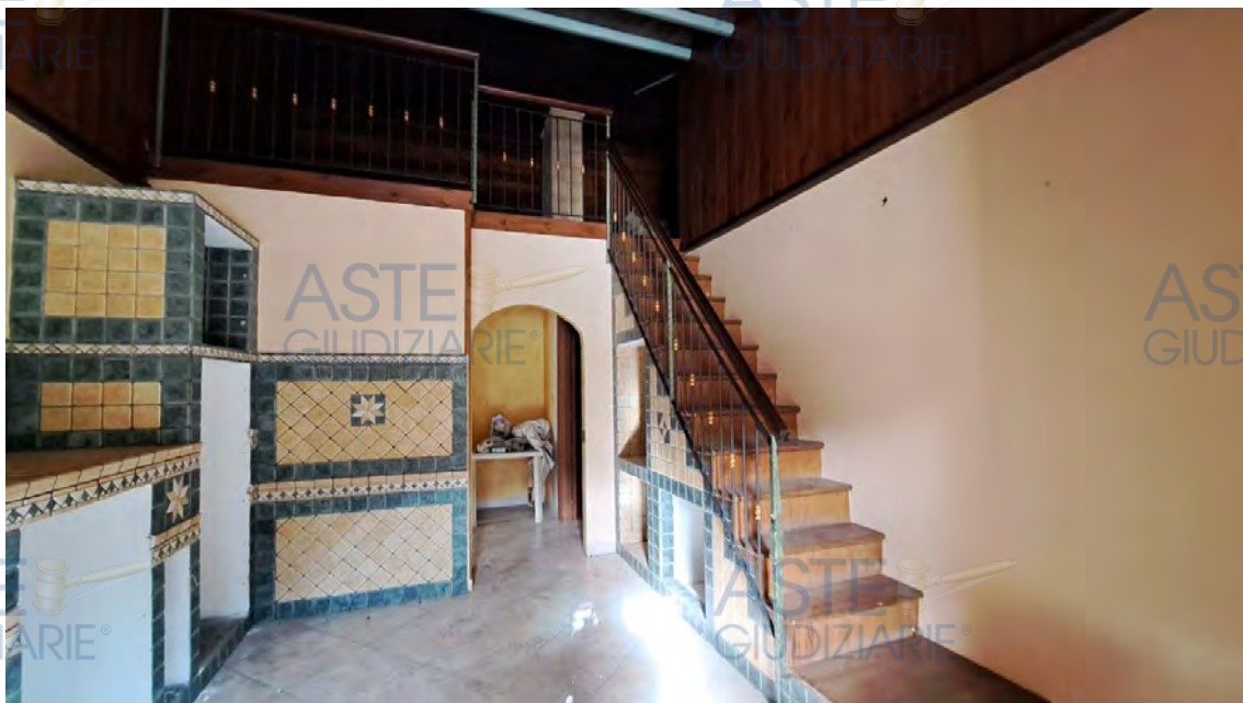
Foto n. 5 – cucina e scala che conduce al sottotetto abusivo
