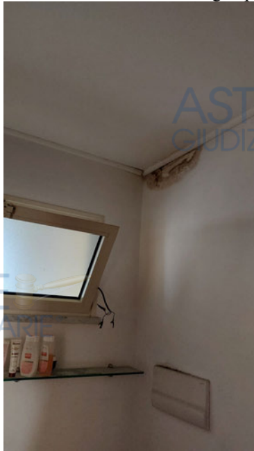
Foto 24 – Tracce umidità bagno p.p. Foto 25: Tracce umidità cucina p.p.
