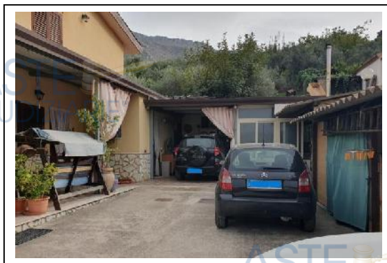
Foto n. 4 corte e tettoie, prospetto ovest
