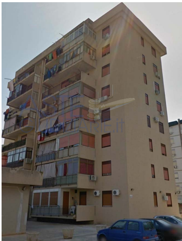
Foto 20 - prospetto su via Bartolomeo Sirillo
