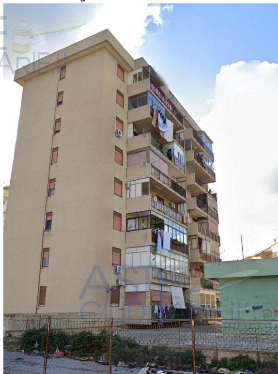
Foto 19 – prospetto su via Bartolomeo Sirillo
