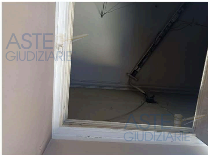
Foto 8: botola nel controsoffitto per accesso all'intercapedine
