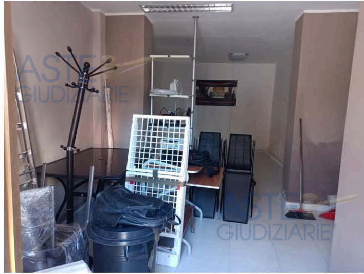
Foto 4: interno del locale. Effetti di umidità di risalita a destra
