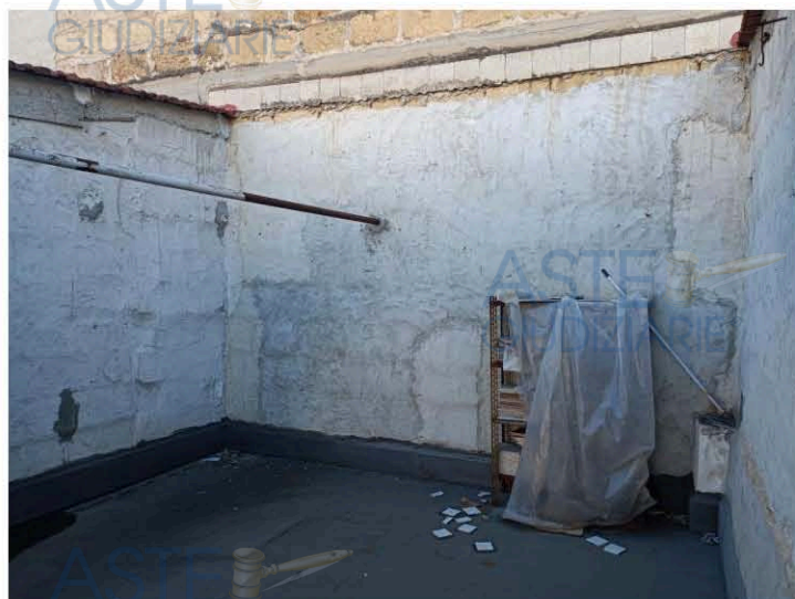
Foto 4: interno dell'unità e interno della facciata di prospetto ristagno sull'impermeabilizzazione
