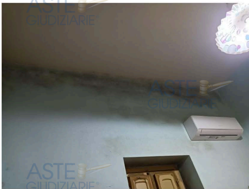
Foto 8: effetti di condensa più accentuati nella stanza dalla cucina in fondo a destra (oltre che nel wcd)
