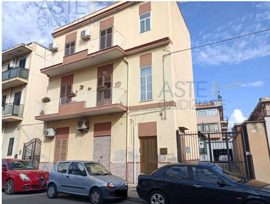
Foto 1: palazzina di ubicazione dell'appartamento
