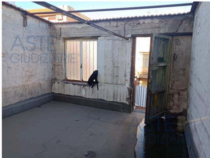
Foto 4: interno dell'unità e interno della facciata di prospetto ristagno sull'impermeabilizzazione
