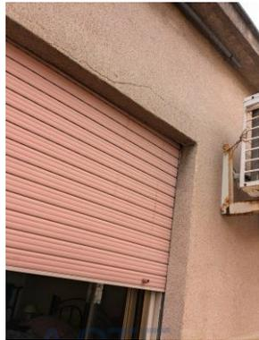
Foto 18: Dettaglio infissi, avvolgibili, e piccole lesioni intonaco.
