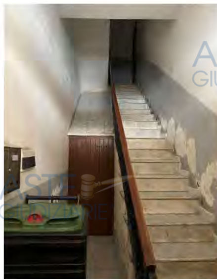
Vano scala di accesso ai piani
