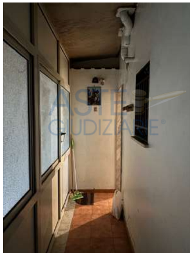
foto n. 9: ballatoio condominiale coperto
