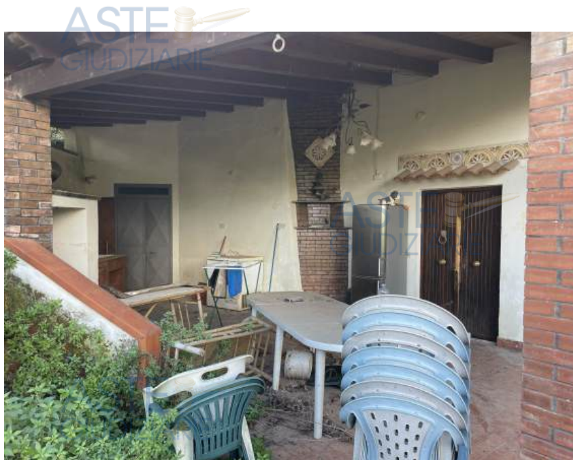
Foto n. 14 – Vista ingresso unità immobiliare
