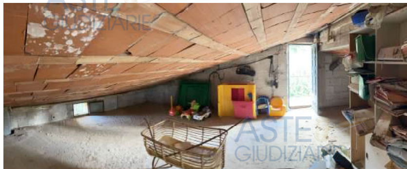
Foto n. 24 – Vista secondo piano sottotetto
