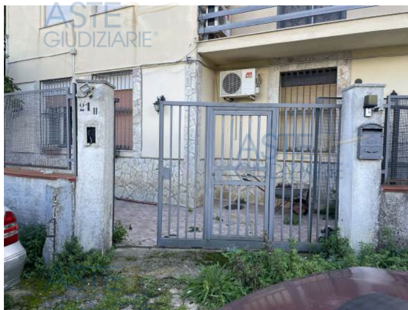
Foto n. 2 – Vista ingresso principale
