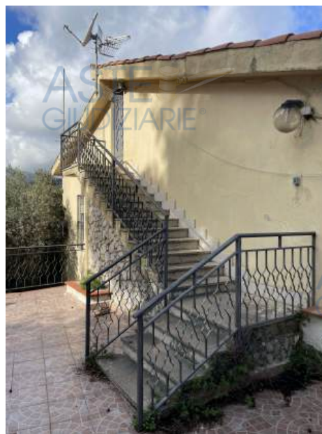
Foto n. 4 – Vista prospetto secondario
