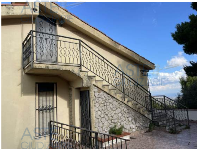
Foto n. 5 – Vista prospetto secondario
