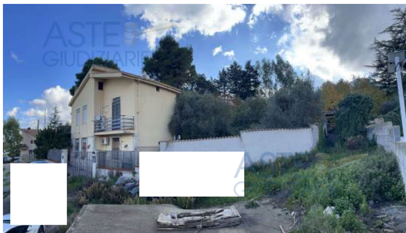
Foto n. 1 – Vista prospetto principale da strada interpodereale
