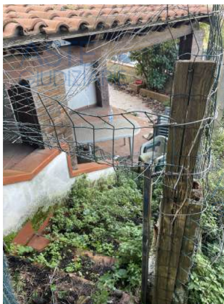
Foto n. 7 – Vista scala esterna
