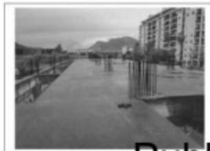
Foto 78. Edificio in corso di costruzione. Estradosso del solaio del piano terra
