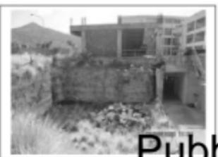
Foto 90. Scavo di sbancamento del prolungamento dell'edificio in corso di costruzione
