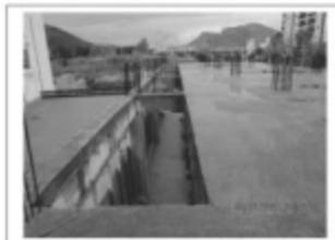
Foto 77. Edificio in corso di costruzione. Estradosso del solaio del piano terra
