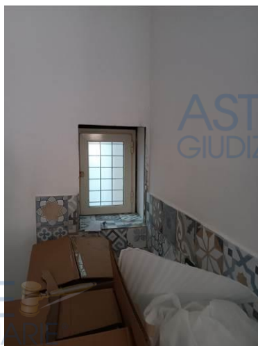
Fig. 22 Particolare zona cottura.
