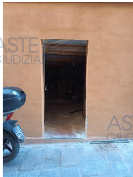
Fig. 12 Ingresso unità civico 8.
