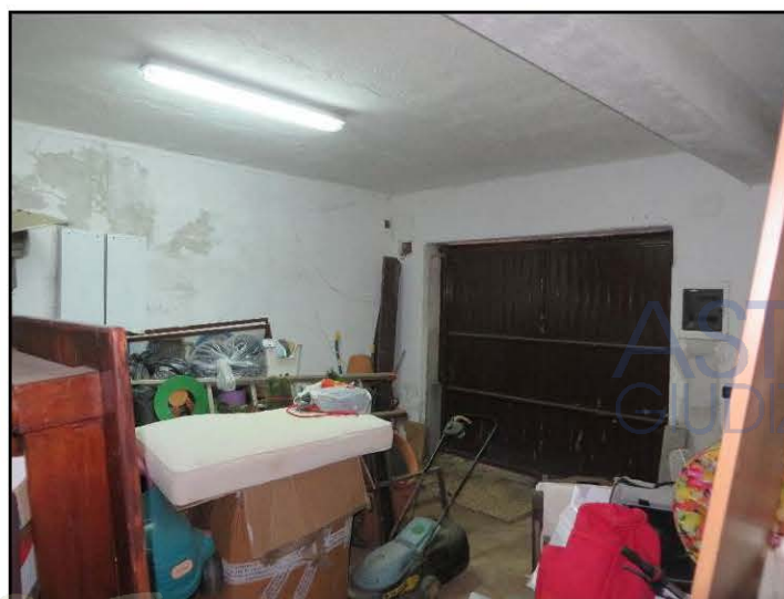
Interno del garage
