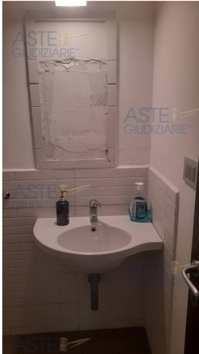
Foto N. 11: Vista del WC principale
