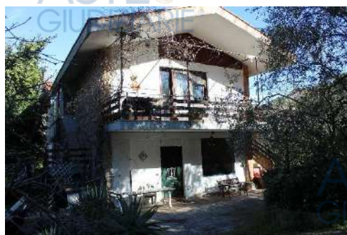
Vista del villino-prospetto principale
