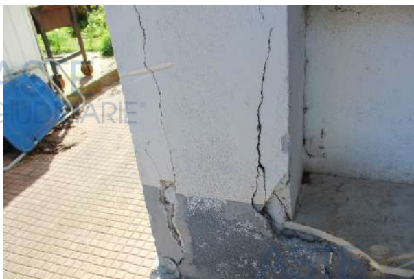
Vista parete esterna-pilastro d'angolo
