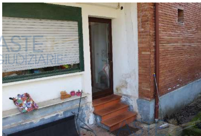
Vista parete esterna-basamento
