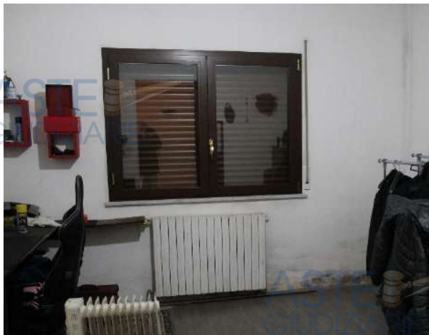
Vista parete interna vano L2
