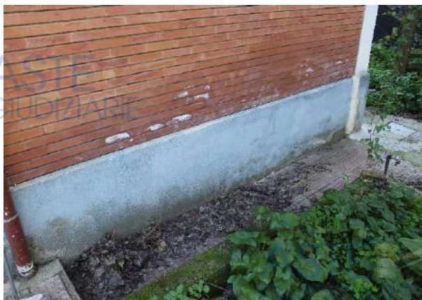
Vista parete esterna-basamento
