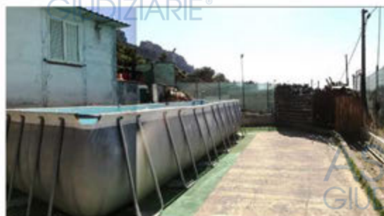
Foto 5 area antistante il prospetto Nord del fabbricato
