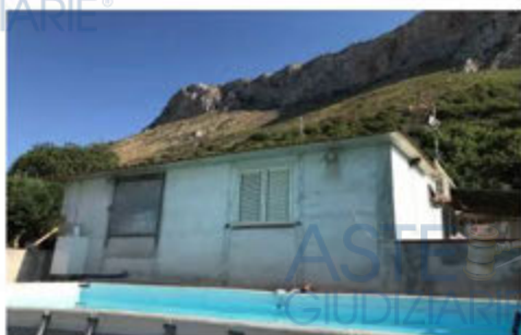
Foto 4 prospetto Nord del fabbricato
