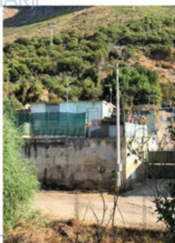
Foto 1 vista del fabbricato dall'autostrada
