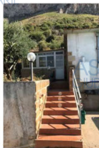
Foto 3 accesso all'abitazione lato Nord
