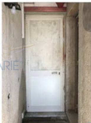
Foto 9 accesso all'abitazione dal lato Sud
