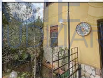
Fig.8 Fronte principale nord-est
