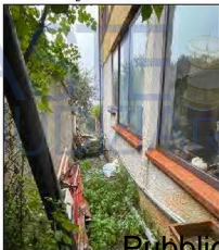
Fig.28 Parete esterna del portico
