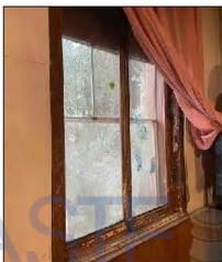
Fig.37 Ossidazione di infisso in ferro
