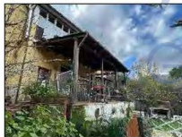
Fig.7 Fronte principale nord-est
