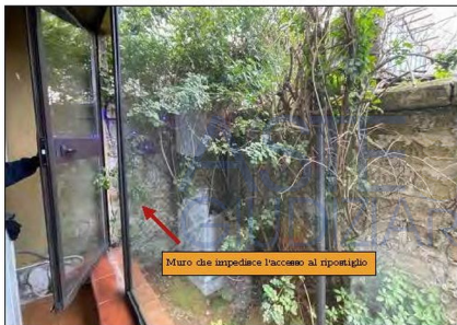
Fig.29 Muro realizzato tra l'unità immobiliare oggetto di procedura e la proprietà del piano sovrastante che impedisce l'accesso al ripostiglio
