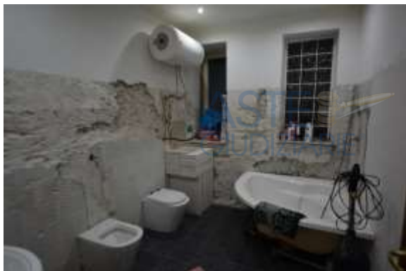
All. 9 – Foto 7 Wc bagno
