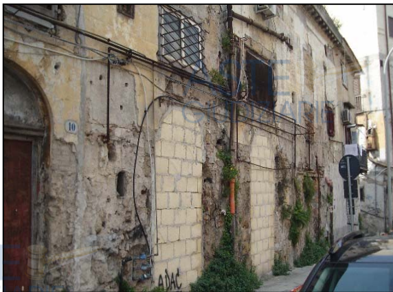
Foto n. 3 - Vista esterna edificio
