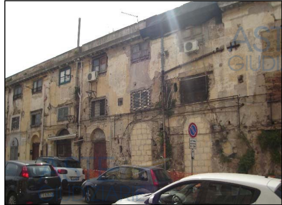
Foto n. 2 - Vista esterna edificio
