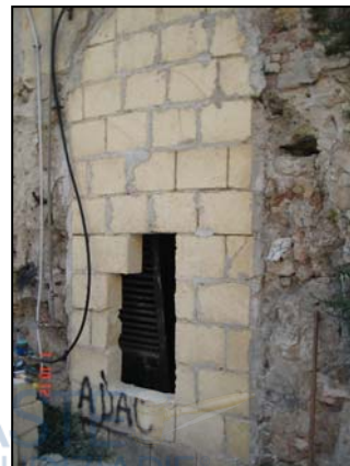
Foto n. 4 - Vista vano di accesso
