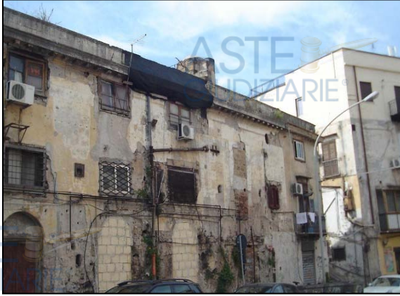
Foto n. 1 - Vista esterna edificio
