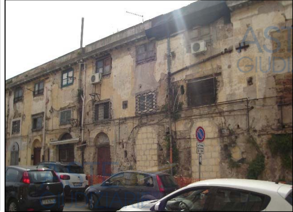
Foto n. 2 - Vista esterna edificio
