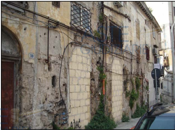
Foto n. 3 - Vista esterna edificio
