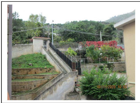
Foto 7. Scala esterna che collega il cancello di ingresso pedonale situato nella parte più elevata di via alla Falconara n. 17 con lo spazio esterno del complesso residenziale ubicato ad una quota inferiore
