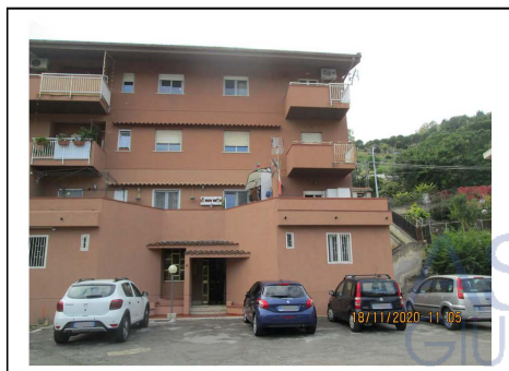
Foto 3. Il prospetto principale del fabbricato di cui fa parte l'immobile pignorato
