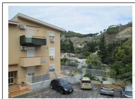
Foto 6. Spazio esterno del complesso residenziale di via Alla Falconara n. 17/C
