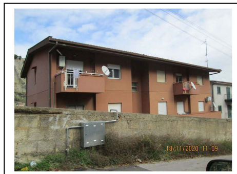
Foto 2. Il prospetto posteriore sud dell'edificio di cui fa parte l'immobile pignorato
