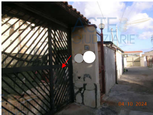
Foto 1– Via Granada 16 – Cancelli di ingresso
