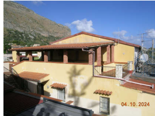
Foto 6 – Prospetto fronte sud
