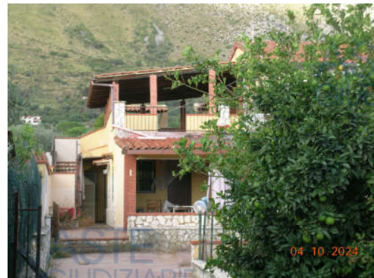
Foto 2 – Prospetto principale fronte est
