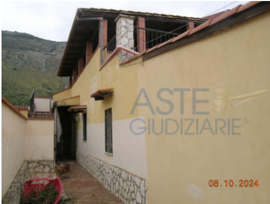
Foto 5 – Prospetto fronte sud
