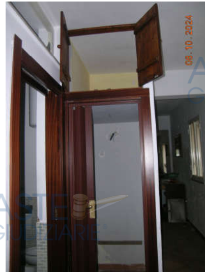
Foto 14 – Disimpegno vani ripostiglio e wcd
