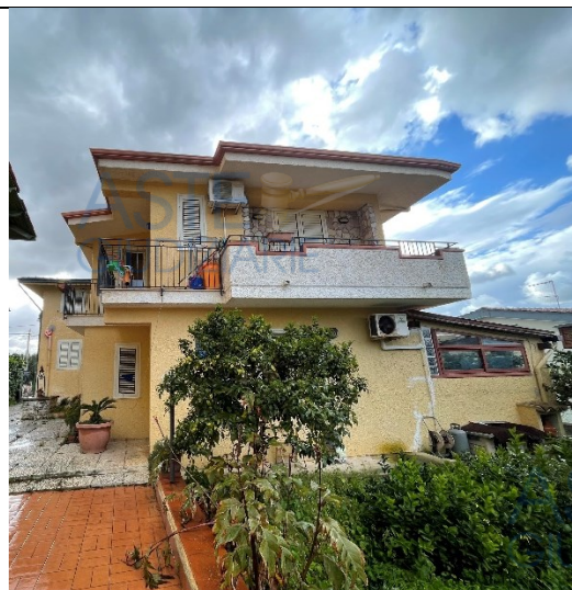
Prospetto est sub 3
