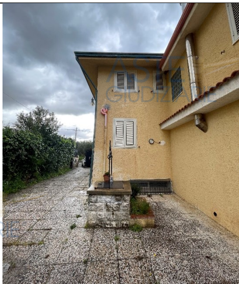
Prospetto est sub 2
