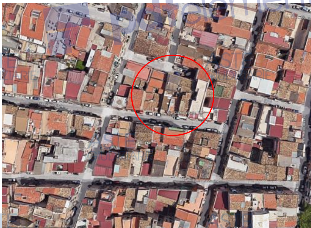
-Vista aerea con indicazione del fabbricato pignorato-
