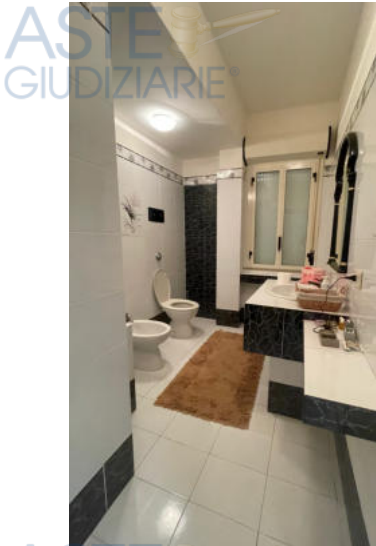
Vista del vano wc 1
