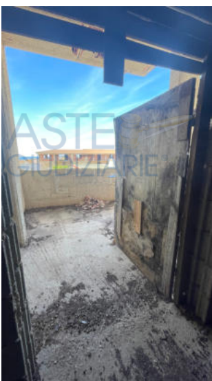
vista del terrazzo - ingresso P1
