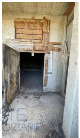
vista ingresso piano 1
