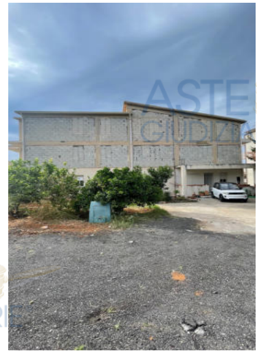
vista prospetto retrostante
