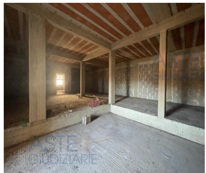
vista del locale piano primo
