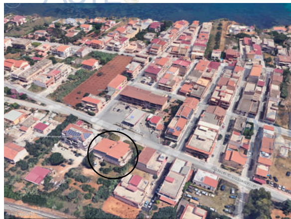
Vista aerea dell'isolato (da Google Heart Pro)
