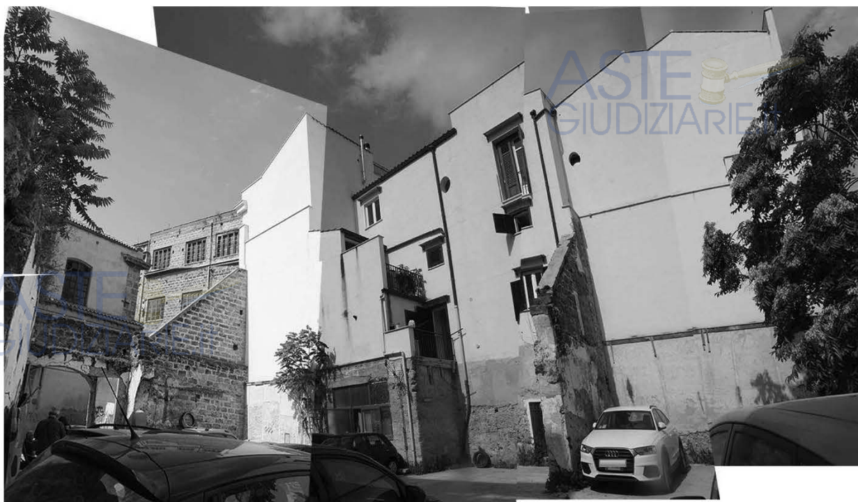
Foto n.8: fg. 131, part.IIa 839 sub 2
