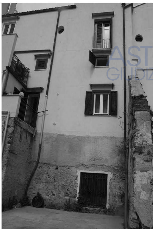
Foto n.9: part.IIa 839 sub 2 – edifici a confine
