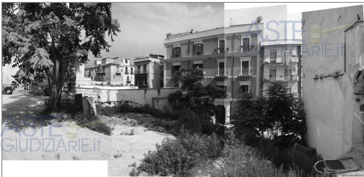
Foto n. 5: part.lla 845 – sub 4 e 5 – vista dalla part.lla 839 verso via dei Candelai
