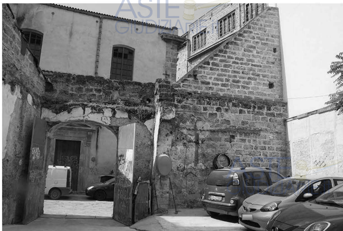
Foto n.7: ingresso da Via dei Candelai – fg. 131, part.Ila 839 sub 2
