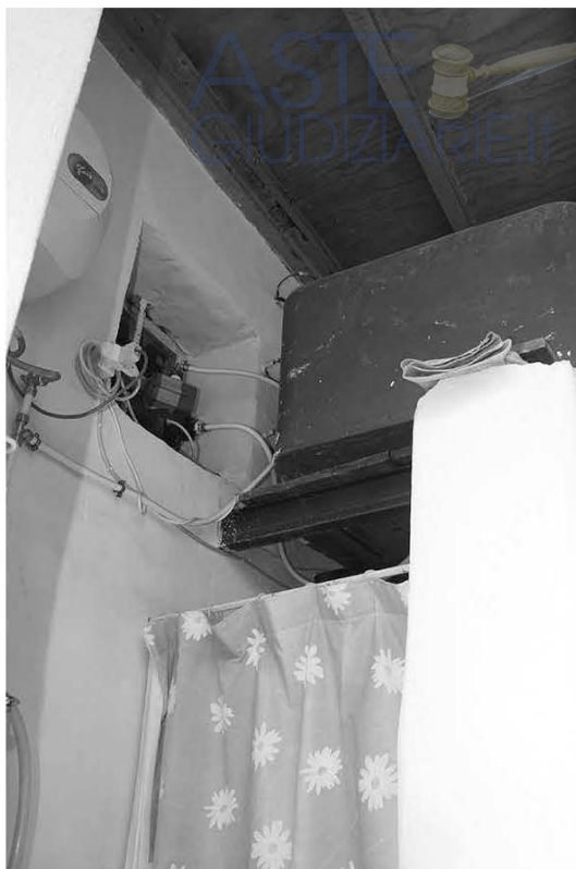
Foto n.17: interno vano verandato
