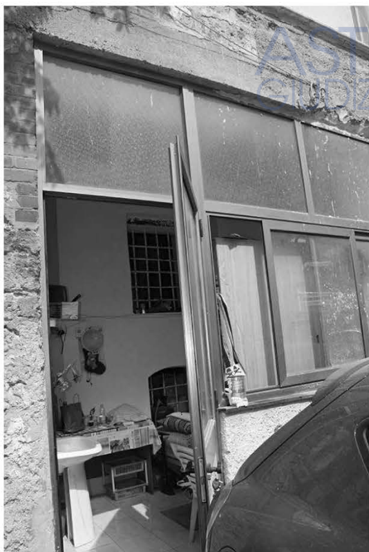
Foto n.14: ingresso al vano verandato
