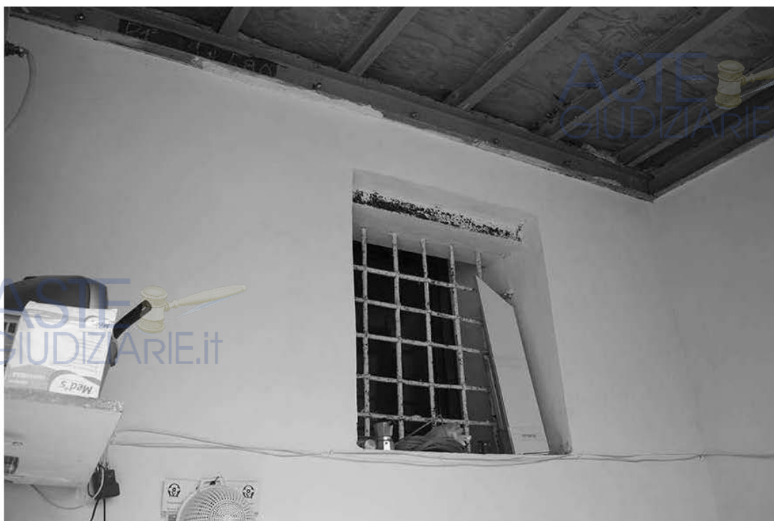
Foto n.19: interno vano verandato
