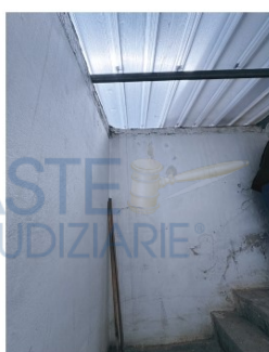
Vano scala da cui si accede all'immobile.
