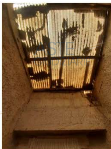
Copertura con ondulina in pvc del pozzo luce
