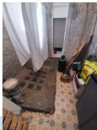
pozzo luce con accesso dalla cucina
