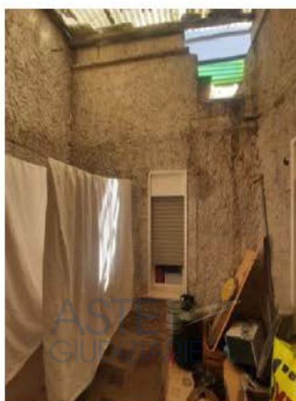
Copertura con ondulina in pvc del pozzo luce
