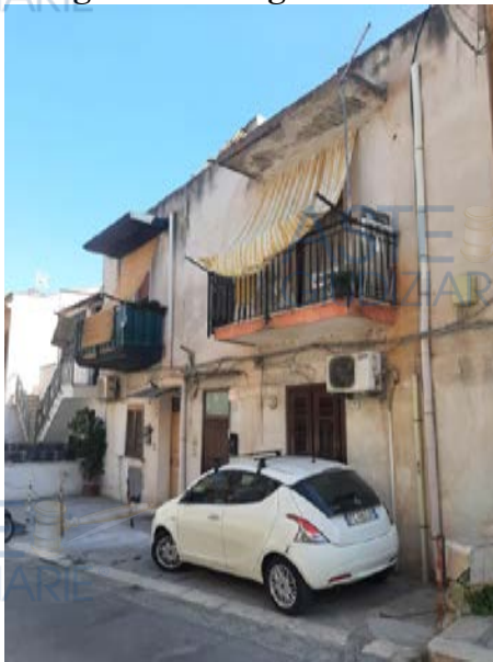
Via Trapani Pescia n.15 (edificio censito alla p.lla 599)
