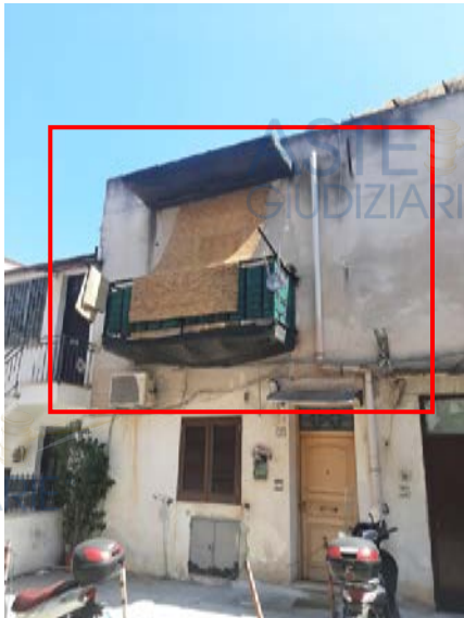
Individuazione balcone di piano 1° su strada
