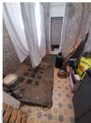
pozzo luce con accesso dalla cucina
