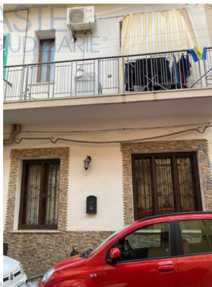
Foto n. 2 prospetto fabbricato su strada
