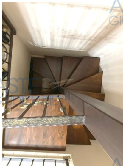
Foto n. 12 scala di collegamento
