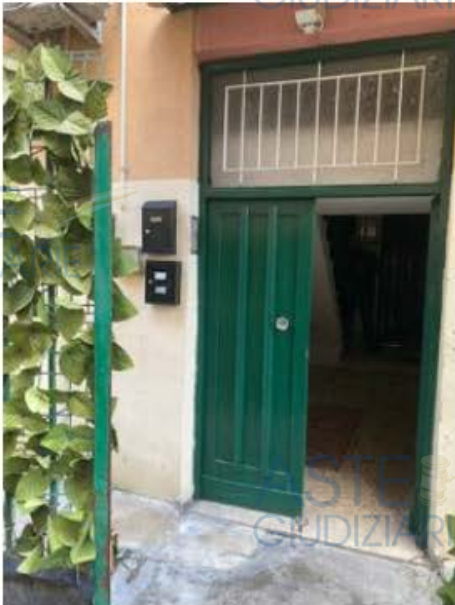
Foto n. 3 Portone di ingresso al fabbricato
