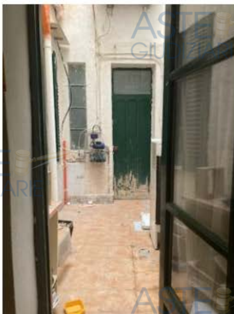
Foto n. 7 vista su chiostina dalla cucina
