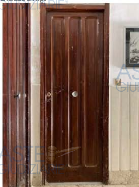
Foto n. 6 porte di ingresso all'appartamento
