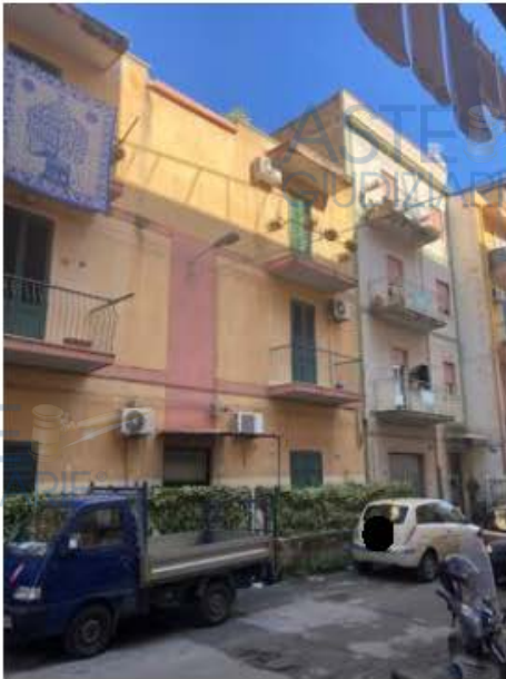
Foto n. 1 prospetto fabbricato su via Anapo
