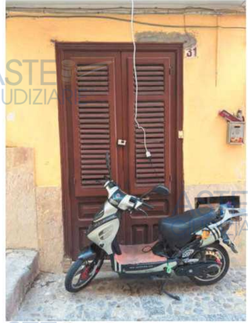
Foto 2 - Ingresso Piano terra civ 31
