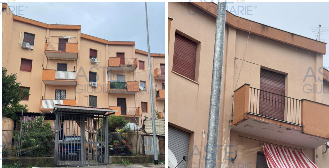
Foto 17-18 – Veduta del retro della palazzina e foto del balcone della camera da letto.
