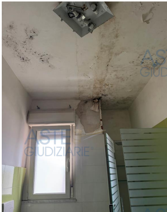
Foto 9-10 – Il WC doccia con le evidenti infiltrazioni che hanno provocato macchie e distacchi
