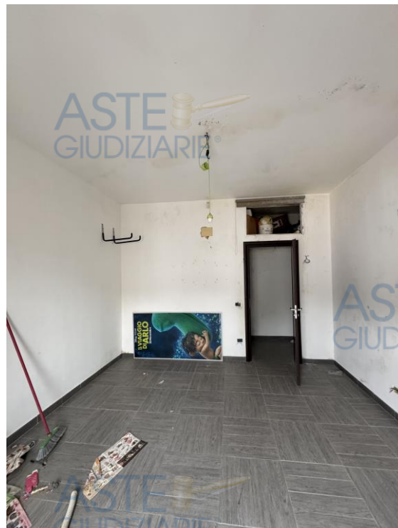
Foto 15-16 – Camera da letto n. 3: sul soffitto sono presenti macchie di umidità dovute a qualche infiltrazione
