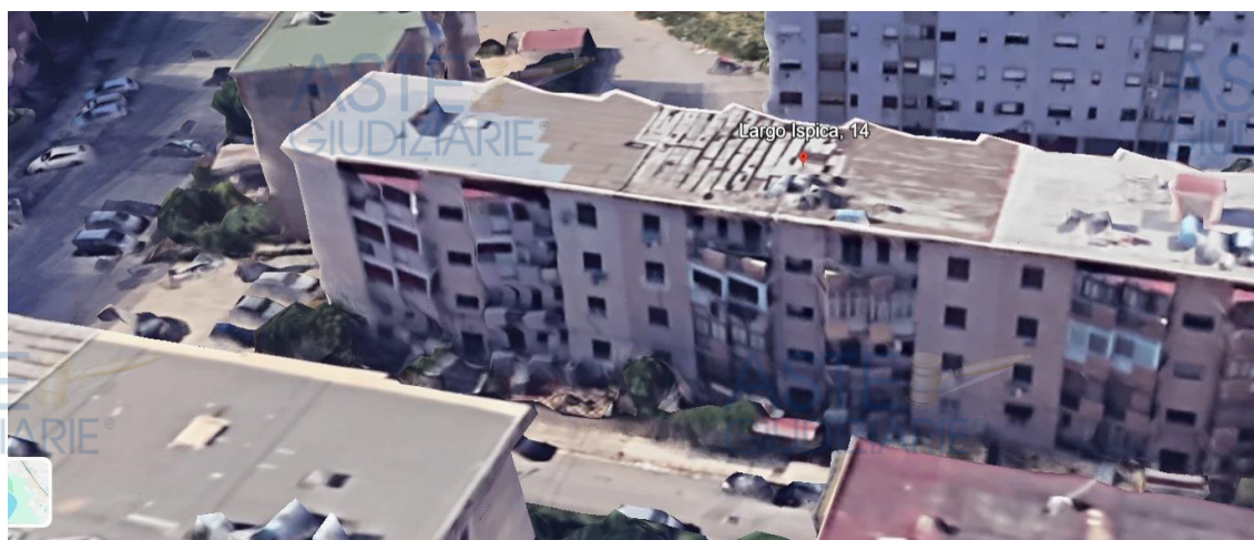
Ortofoto (da Google Earth) che documenta i lavori di ripristino del lastrico solare del 2025
