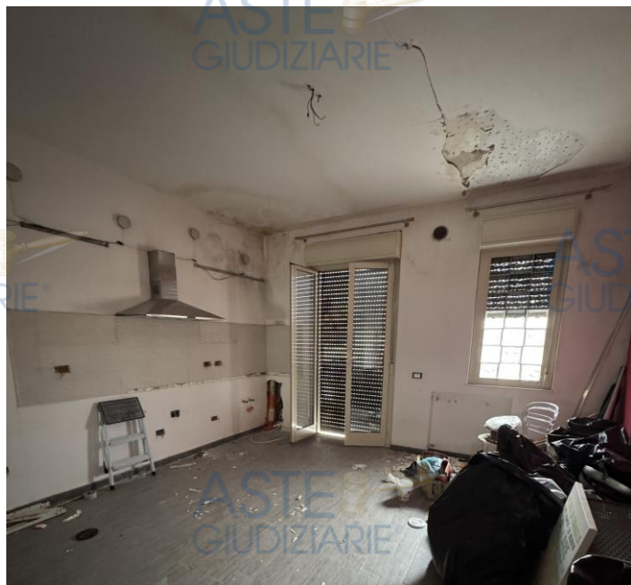
Foto 4 - La cucina soggiorno con le infiltrazioni e il distacco
