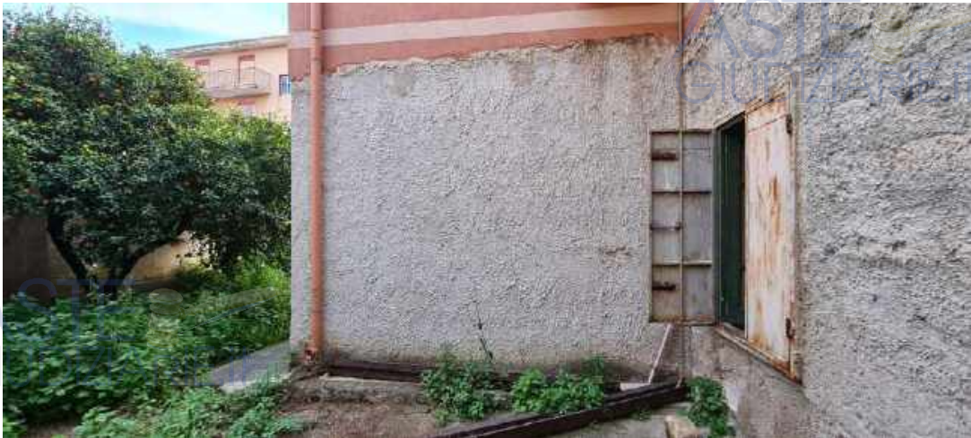
Magazzino/locale deposito-Infisso vano pranzo – Retroprospetto
