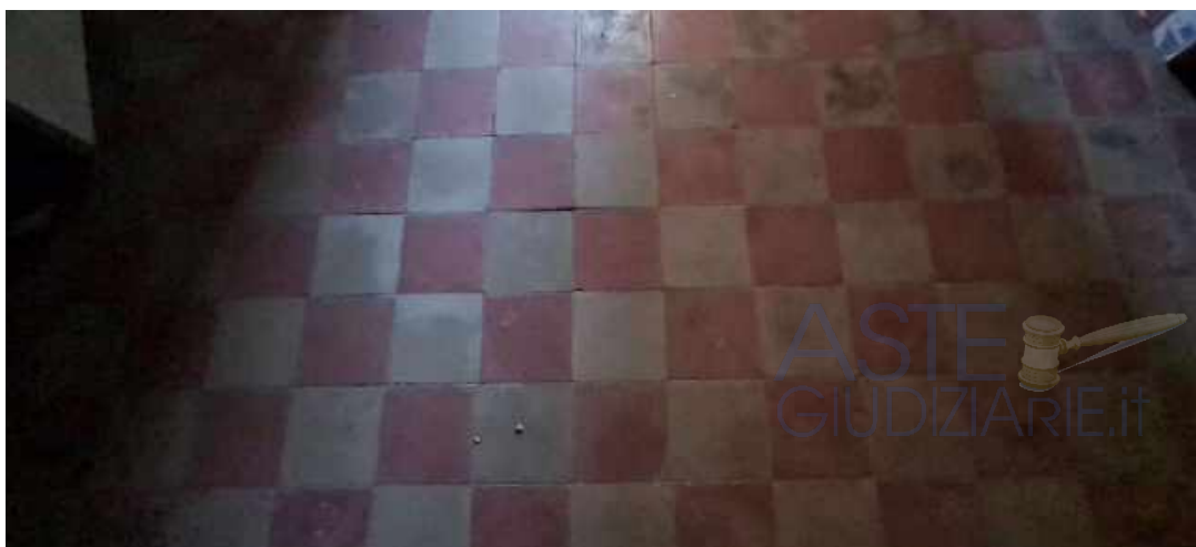
Particolare pavimento con antiche mattonelle cementine sicilia colore rosso e beige
