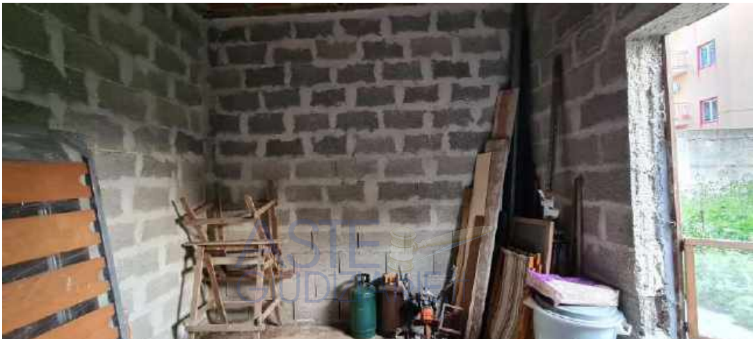
Magazzino/locale deposito – interno
