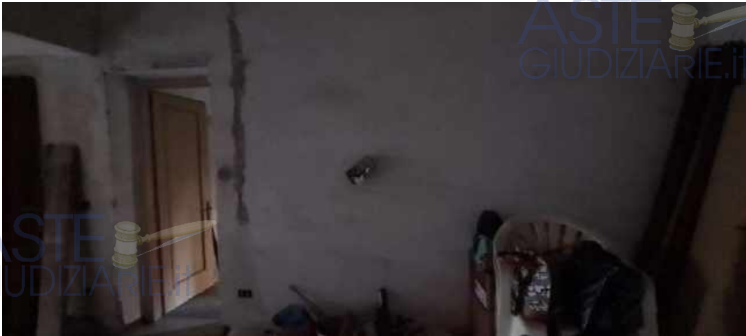
Porta di accesso al vano pranzo
