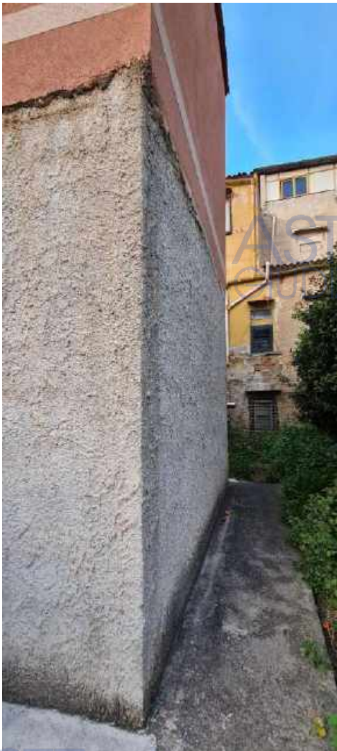
Magazzino/locale deposito- Retroprospetto
