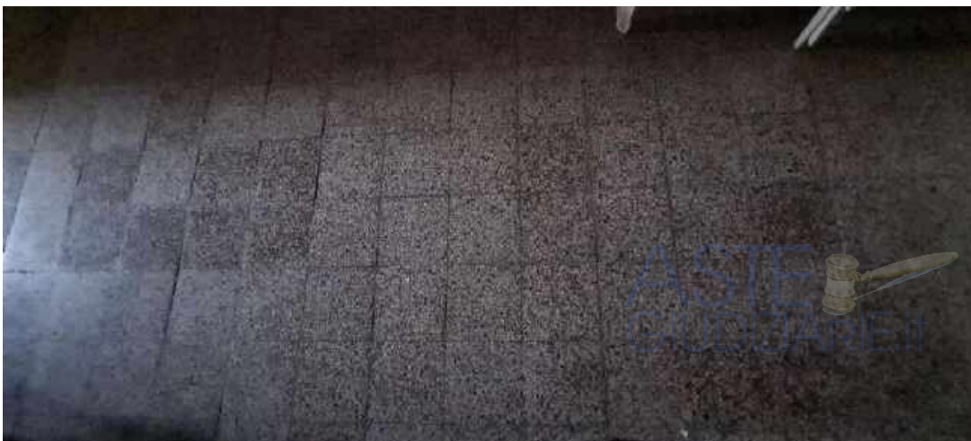
Particolare pavimento in marmette di graniglia di cemento
