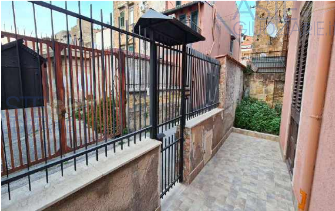
Cancelletto d'ingresso antistante l'abitazione-Area condominiale
