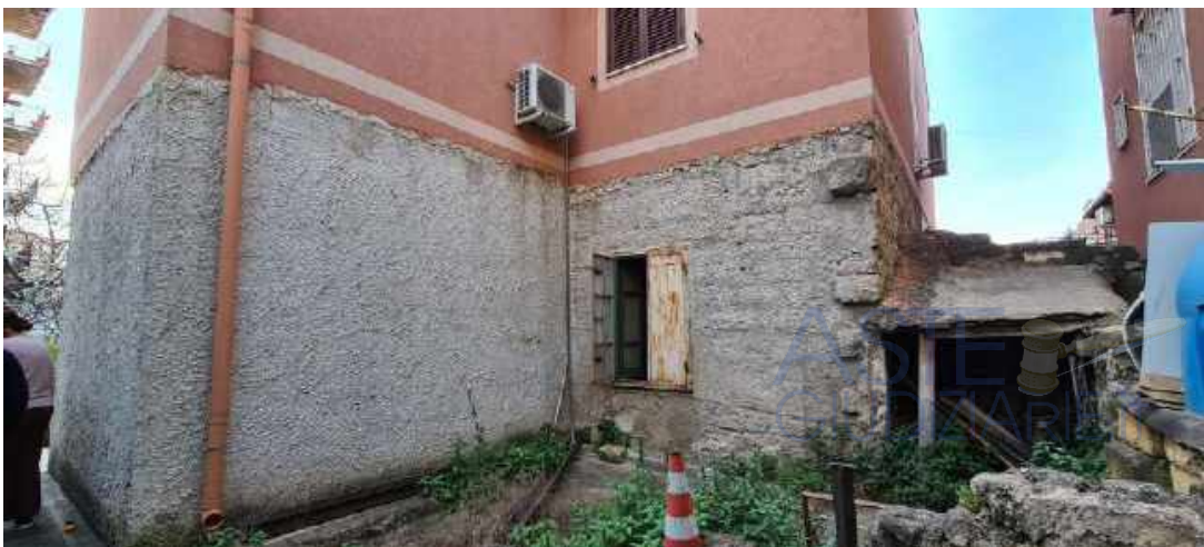
Magazzino/locale deposito-Infisso vano pranzo - Retrospetto
