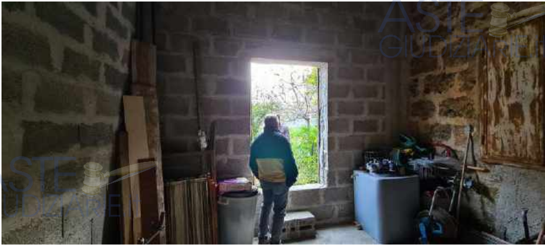
Magazzino/locale deposito – interno
