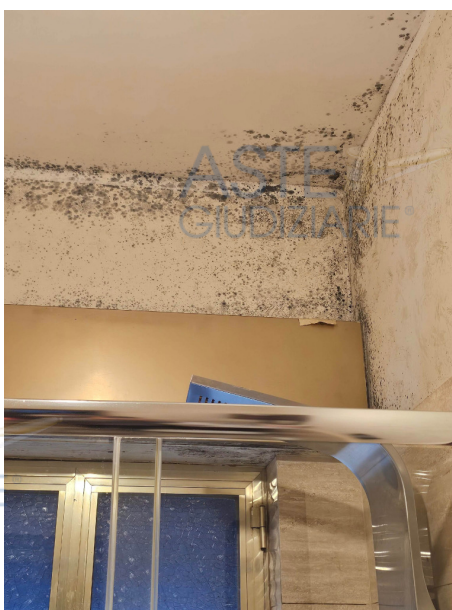
particolare del soffitto all'interno della doccia
