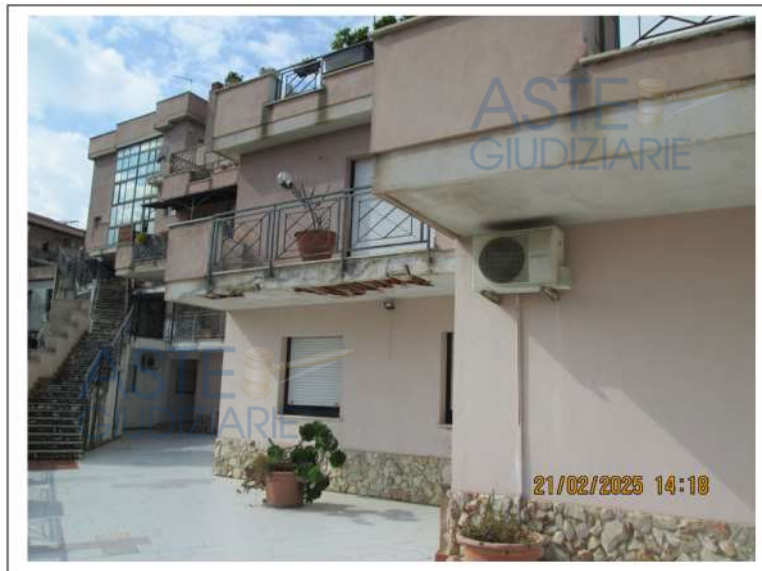
Foto n. 4. Scala esterna di accesso alle unità immobiliari del complesso residenziale.
