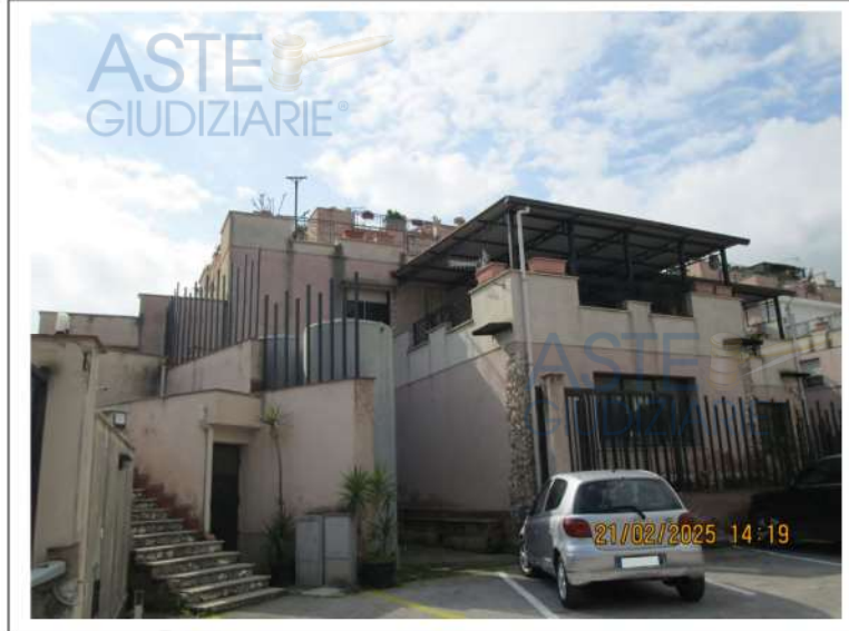
Foto n. 3. Zona adibita a parcheggio e scala esterna di accesso alle unità immobiliari del complesso residenziale
