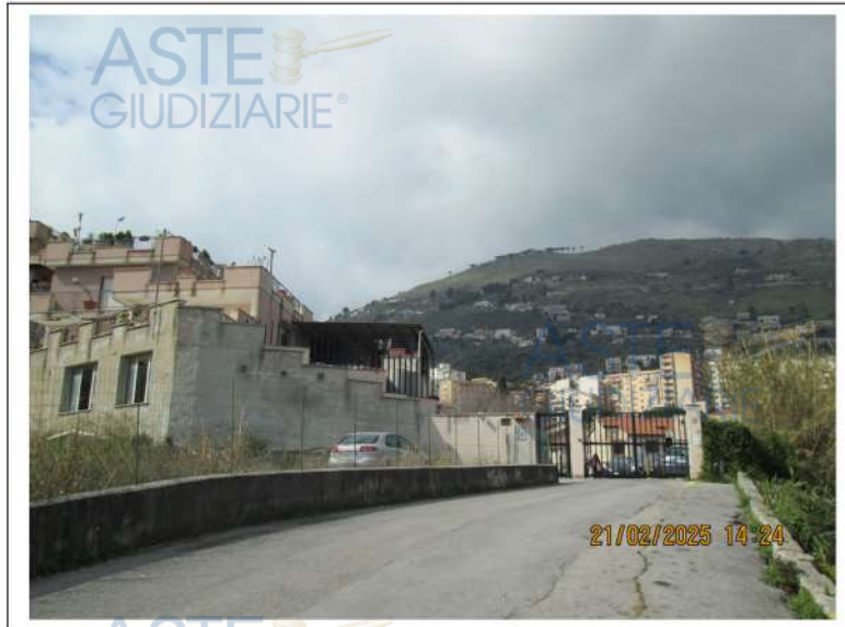
Foto n. 1. Stradella di accesso dalla via Circonvallazione al complesso residenziale di cui fa parte il bene pignorato
