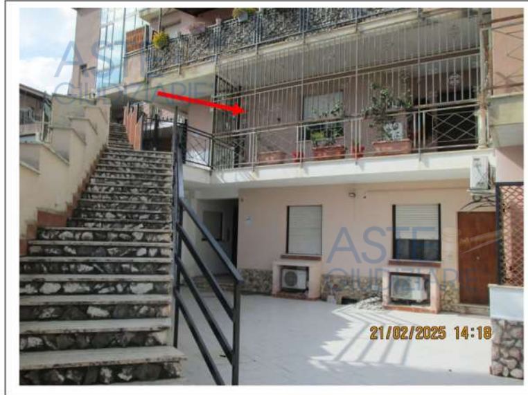
Foto n. 5. Scala esterna di accesso alle unità immobiliari del complesso residenziale. Con la freccia rossa è indicato il balcone/ballatoio di ingresso al bene pignorato
