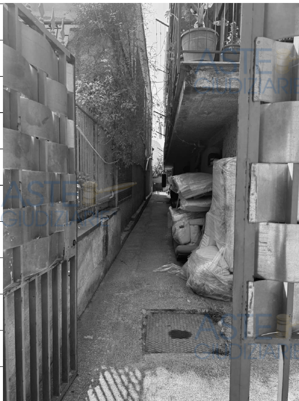
Ingresso cortile interno
