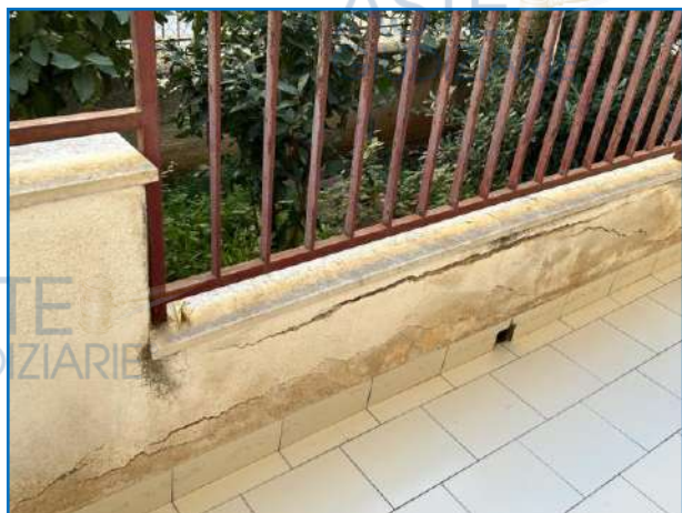
Foto n. 13 Balcone su retro prospetto ammalorato
