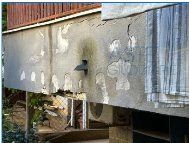
Foto n. 15 Ammaloramento balcone retro prospetto
