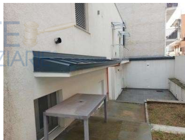
Foto 17 Retroprospetto con accesso al seminterrato
