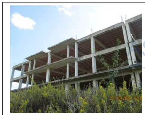
Foto 4. Fabbricato pignorato in corso di costruzione. Fronte nord®
