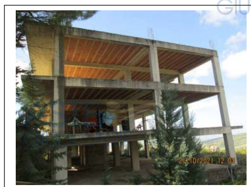
Foto 2. Fabbricato pignorato in corso di costruzione. Fronte est
