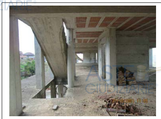
Foto 15. Fabbricato pignorato in corso di costruzione. Piano primo (livello abitazioni)
