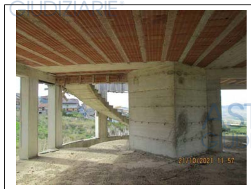
Foto 16. Fabbricato pignorato in corso di costruzione. Piano primo (livello abitazioni)
