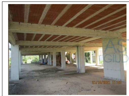
Foto 10. Fabbricato pignorato in corso di costruzione. Piano Terra (livello abitazioni)
