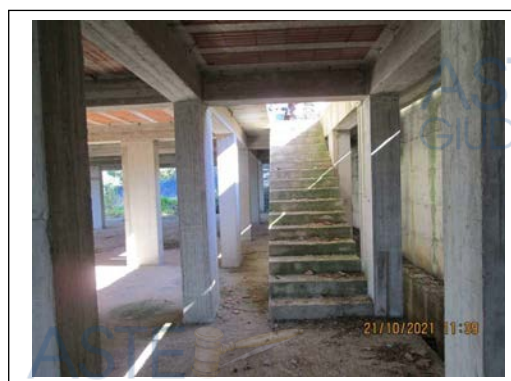
Foto 8. Fabbricato pignorato in corso di costruzione. Piano S1 a livello dei garage. Corpi scala interni
