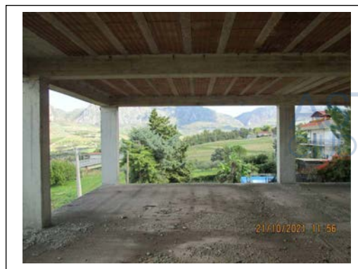
Foto 14. Fabbricato pignorato in corso di costruzione. Piano primo (livello abitazioni)
