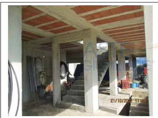
Foto 11. Fabbricato pignorato in corso di costruzione. Piano terra (livello abitazioni)
