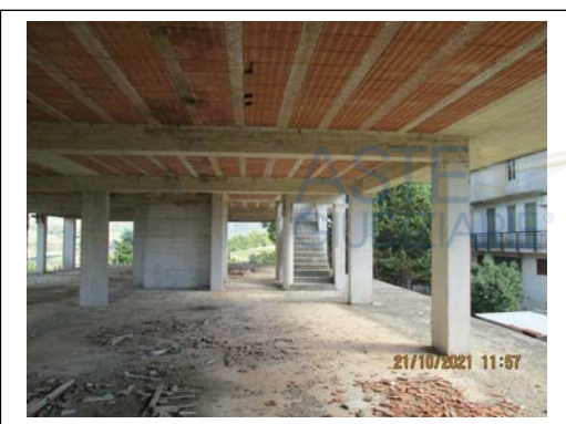
Foto 13. Fabbricato pignorato in corso di costruzione. Piano primo (livello abitazioni)
