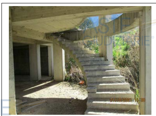
Foto 7. Fabbricato pignorato in corso di costruzione. Piano S1 a livello dei garage. Corpi scala interni
